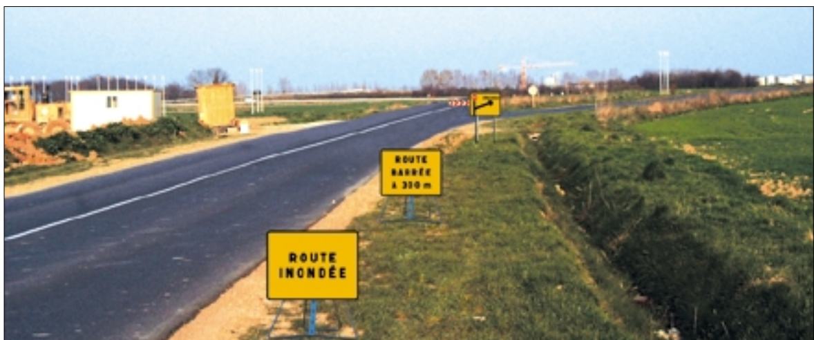
Mise en place d'une déviation à cause d'une inondation : séquence de présignalisation.
