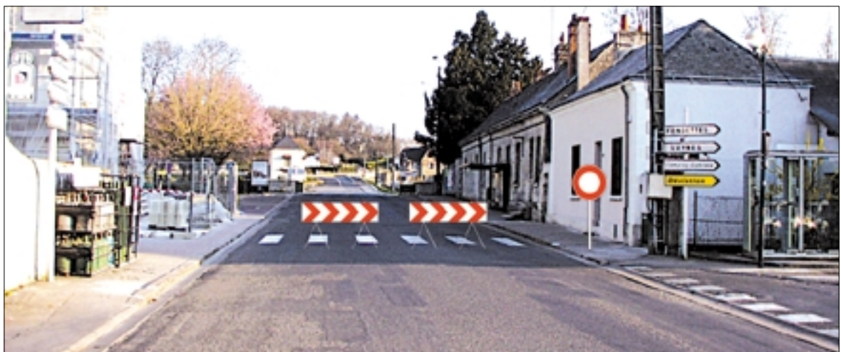
Site d'entrée étanche.
